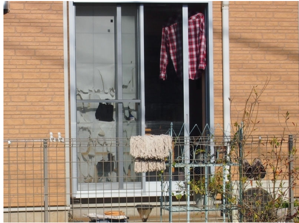
被災した家屋。1 m近く浸水したことがわかる／筆者撮影
